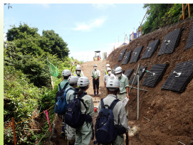
鉄筋挿入の見学
