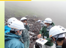
標高約2,100mの工事現場を見学
