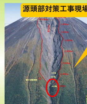
源頭部対策工事現場
