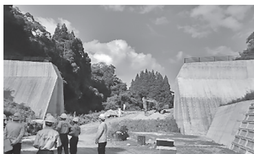
写真-7 砂防堰堤新設現場の見学 (日野川河川事務所)
